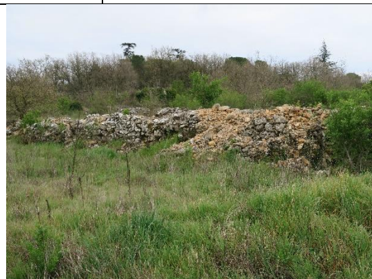
Dégradation des murets
