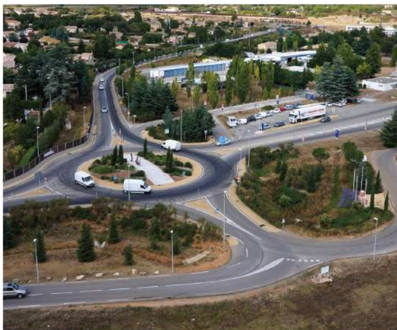
Objectif : début des travaux d'aménagement en 2024.
