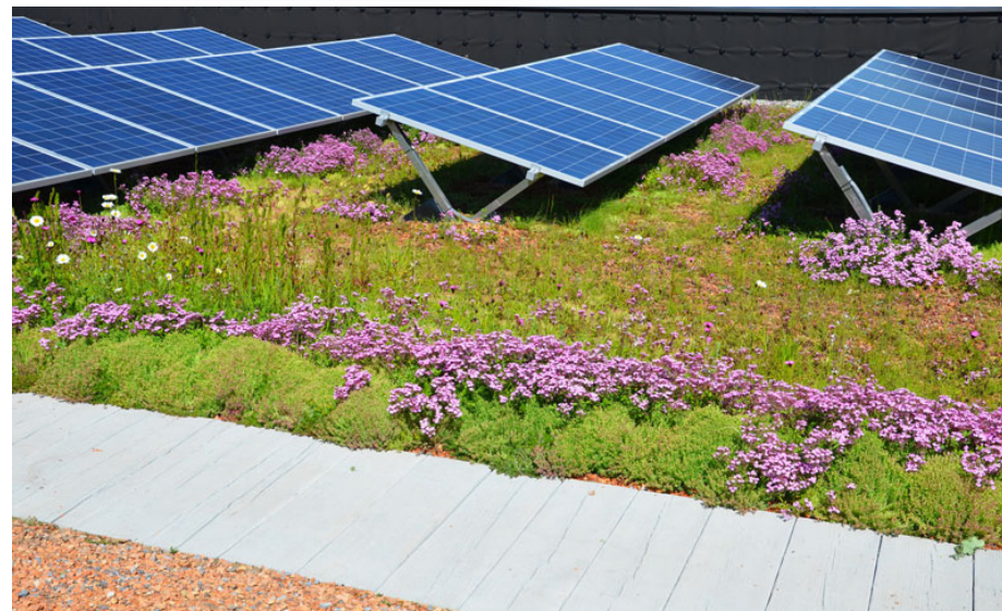
Exemple de toiture mêlant végétalisation et production d'énergie
