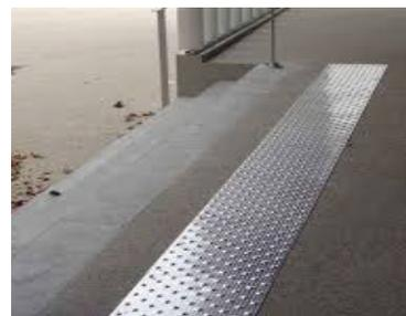
Exemple de dalle podotactile pour alerter les personnes malvoyantes d'un danger (ici d'un changement de niveau).
